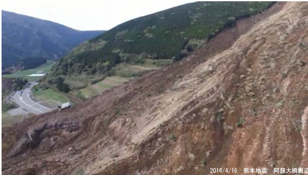
図 2-11 土砂崩落現場における斜め映像の撮影例
